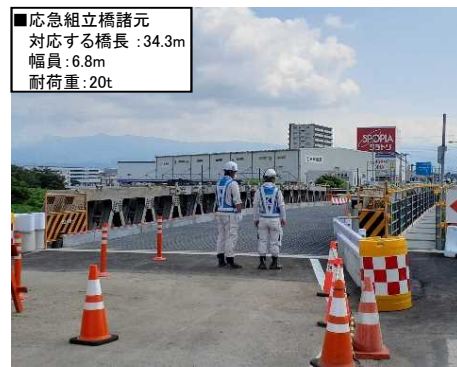
※中部地方整備局所有の応急組立橋を貸与
