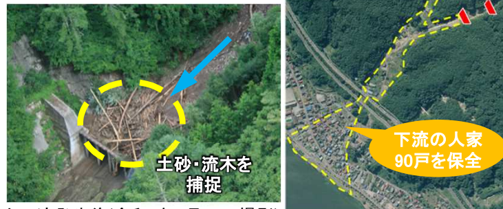
土石流発生後(令和3年8月20日撮影)
