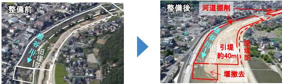
堤防整備(引堤)・河道掘削等を実施
