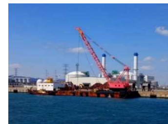
復旧工事中用資材の荷役(相馬港)
