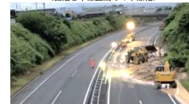
4車線のうち、土砂崩れの被害のない2車線を 活用することで、迅速に通行を確保
