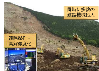
5Gを活用した無人化施工（イメージ）
