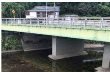
国道3号における対策状況 (鹿児島県いちき串木野市)
