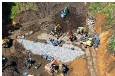
安全対策施工状況 (静岡県熱海市)
