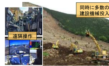
無人化施工(イメージ) 同時に多数の建設機械投入
