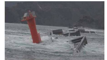
被災した防波堤(釜石港)
