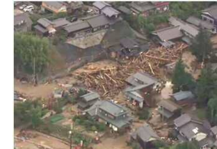
土石流等による被害 (新潟県村上市)
