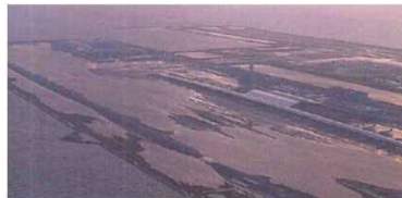
平成30年台風第21号による 関西国際空港の浸水状況
