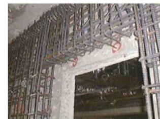
処理場の耐震化躯体補強
