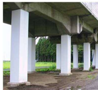
高架橋耐震補強
