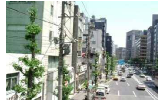
国道1号における整備状況 (整備前) (東京都港区虎ノ門)
