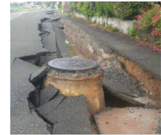
下水道施設（管きよの被災）
