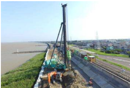
河川堤防の地震対策(木曾川)
