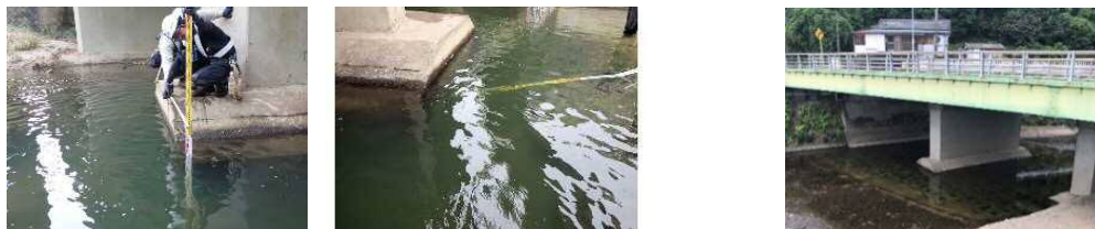
最大1.1mの洗堀を確認 流失防止対策として 工事完成後の状況(令和4年5月完成) 根固め工を実施
