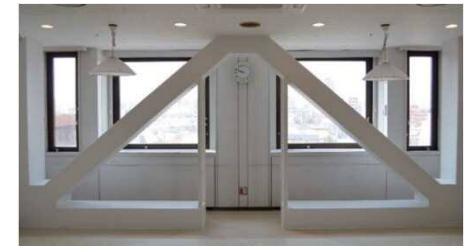
ブレース補強工法
