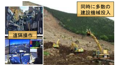
無人化施工(イメージ) 同時に多数の建設機械投入
