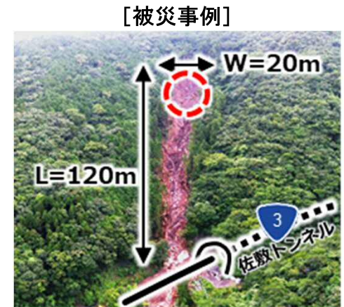
斜面山頂部からの大規模崩落 国道3号 令和2年7月豪雨
