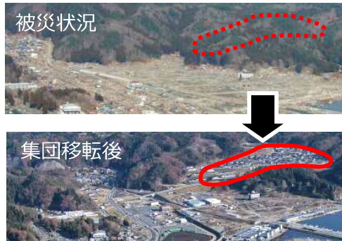
東日本大震災により津波被害を受け、高台に集団移転した事例（岩手県宮古市）
