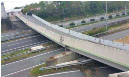
緊急輸送道路上の橋梁の崩落
