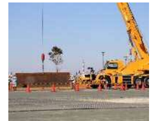
防災拠点等応急復旧訓練
