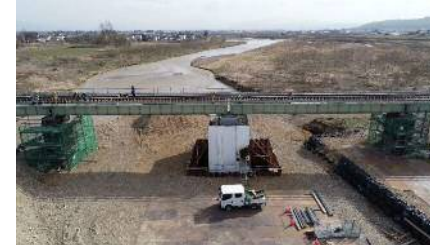
橋梁復旧(磐越西線)
