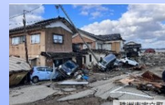
津波による浸水被害（珠洲市宝立町）
