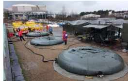
▲自衛隊と連携した仮設風呂への給水活動
