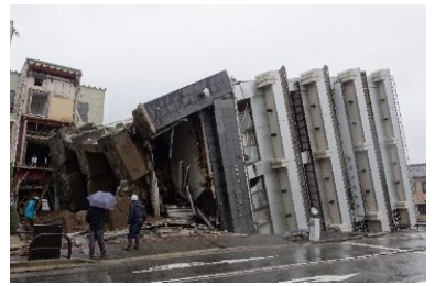
＜建築物の転倒被害＞
