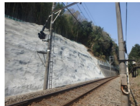
<法面固定の実施状況>
