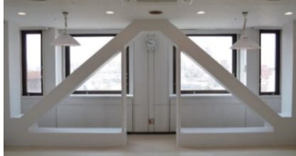
ブレース補強工法
