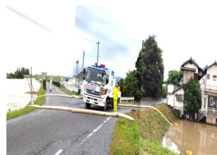
排水ポンプ車による排水活動 (福岡県久留米市)
