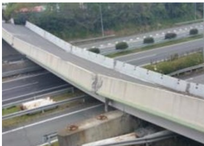
九州自動車道をまたぐロッキング橋脚の落橋 (県道小川嘉島線・府領第一橋)
