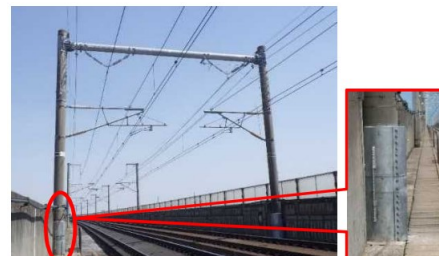
電柱の補強 下部補強
