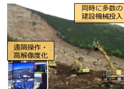
無人化施工(イメージ)
