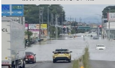
国道1号の冠水状況（愛知県豊川市）
