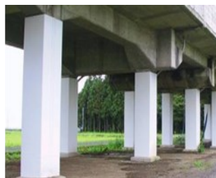
高架橋耐震補強
