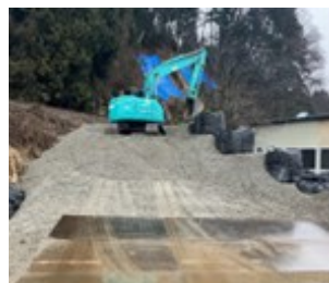
事業間連携による進入路の造成
