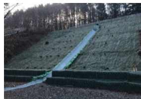
のり面復旧(JR北海道)
