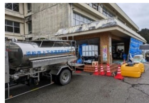
避難所への給水活動状況
