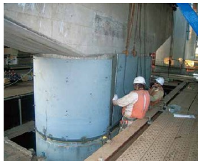
鋼板巻き立てによる補強工事
