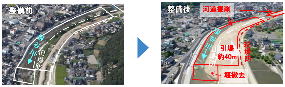
堤防整備(引堤)・河道掘削等を実施
