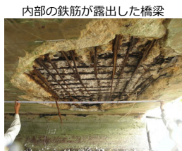
内部の鉄筋が露出した橋梁
