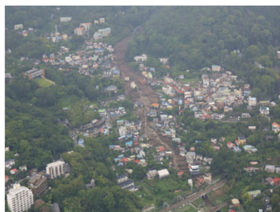
静岡県熱海市の被害状況 (令和3年7月)
