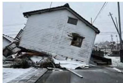
＜木造住宅の被害＞
