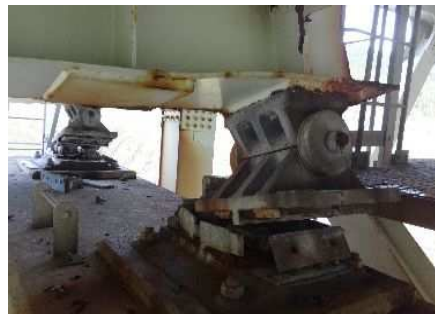
橋梁の支承の損傷 (大分自動車道・並柳橋)
