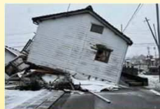
木造住宅の被害
