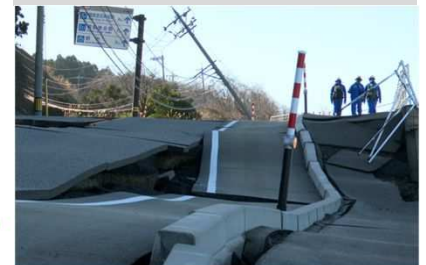
国道249号道の駅千枚田付近の被害（石川県輪島市）
