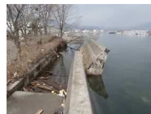
被災した海岸堤防(大船渡港海岸)
