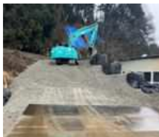
事業間連携による進入路の造成
