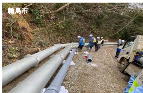
被災した上下水道施設の仮配管 (左:水道管 右:下水道管)
