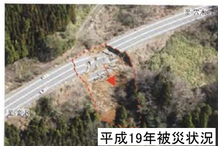
上下線の崩落（H19.3月）
