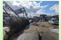
液状化被害の状況（石川県）
