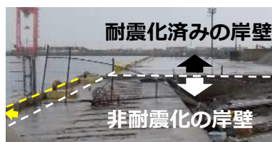
東日本大震災で被災した一般岸壁と耐震強化岸壁(仙台塩釜港)
