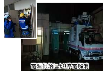
電源供給により停電解消
