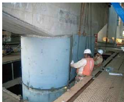
鋼板巻き立てによる補強工事
