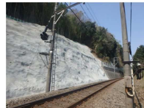
<法面固定の実施状況>
