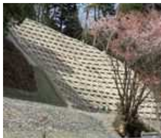
斜面復旧(のと鉄道)
