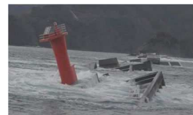
被災した防波堤(釜石港)
