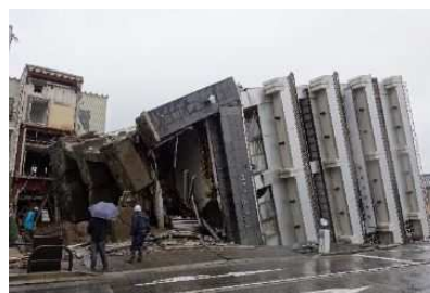
＜建築物の転倒被害＞
