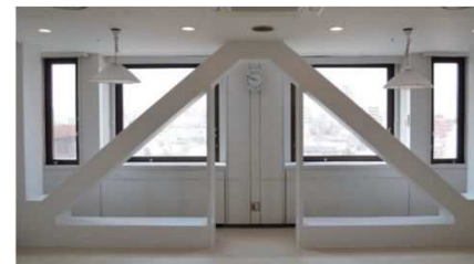
ブレース補強工法
