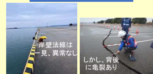
発災直後の七尾港耐震強化岸壁
