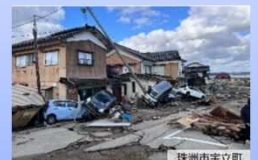
津波による浸水被害 （珠洲市宝立町）
