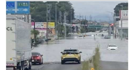
国道1号の冠水状況（愛知県豊川市）
