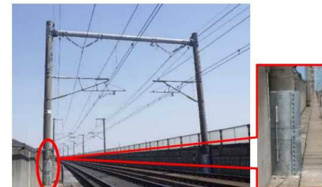
電柱の補強 下部補強
