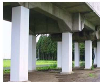
高架橋耐震補強
