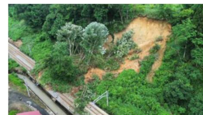
土砂流入(JR東日本奥羽線)
