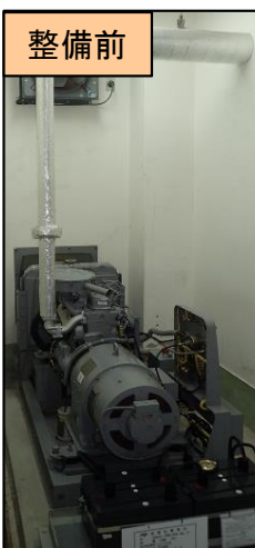
非常用電源設備の換装
