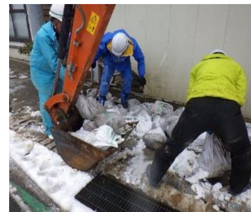
工事業者による土砂回収状況
