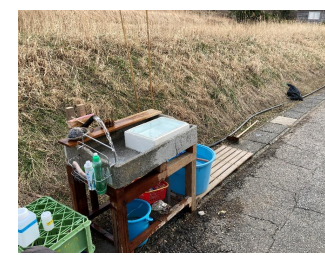
湧水に配管を敷設し、 生活用水に利用(珠洲市)
