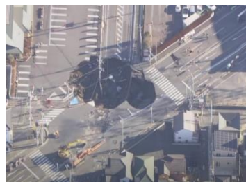
1月31日時点の 事故現場の状況
