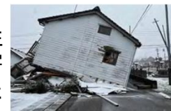
能登半島地震での 木造住宅の被害
