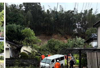
熊本県上益城郡甲佐町豊内 死者1名、人家半壊2戸、 一部損壊3戸
