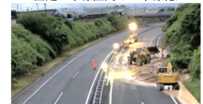
4車線のうち、土砂崩れの被害のない2車線を活用することで、迅速に通行を確保
