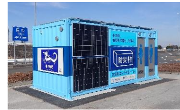
防災用コンテナ型トイレ
