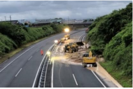
被害のない2車線を活用し、交通機能を確保 (九州自動車道(横川～清辺鹿兒島空港))
