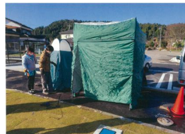
マンホールトイレの 設置(穴水町)
