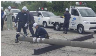
電力事業者による倒壊電柱の除去訓練
