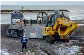
自衛隊と連携した海路を活用した道路啓開用重機の運搬
