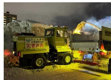
支援機械による排雪作業(札幌市)
