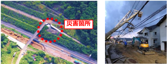
東九州自動車道 暫定2車線 令和6年能登半島地震で倒壊した ⇒約2か月間全面通行止め 電柱の状況(石川県輪島市)
