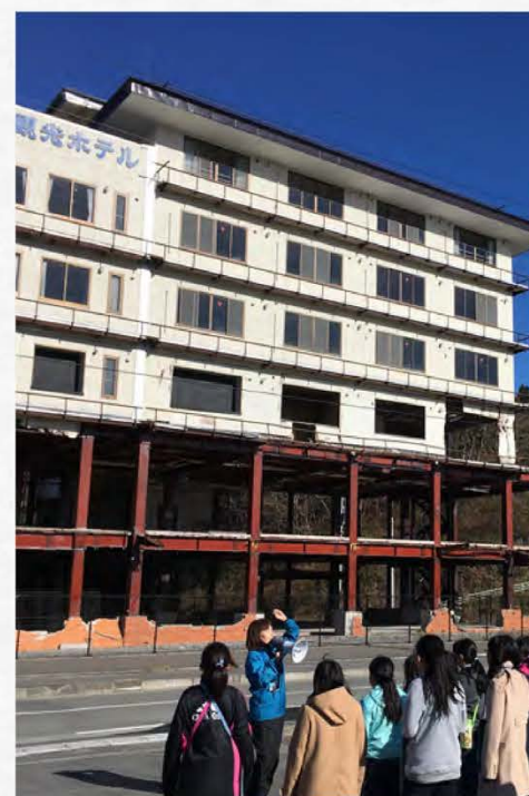
4階まで浸水し破壊された「たろう観光ホテル」が活用されている。
