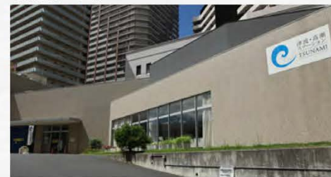
「津波・高潮ステーション」外観
