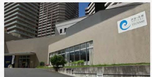
「津波・高潮ステーション」外観
