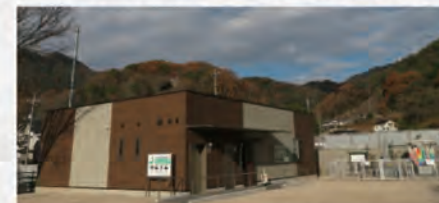
園内に「坂町災害伝承ホール」の外観
