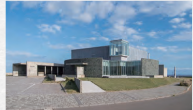
「奥尻島津波館」の外観
