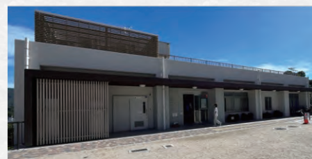
「広島市豪雨災害伝承館」外観
