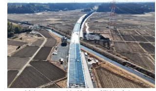
首都圏3環状道路の機能確保 首都圏中央連絡自動車道（大塚～横芝：R6年度開通予定）
