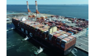
大水深コンテナターミナルの整備（横浜港）
