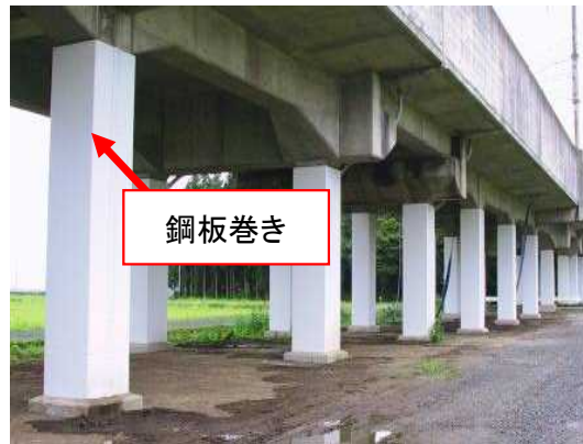
高架橋の補強
