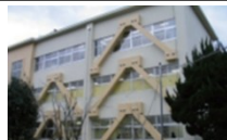
建築物の耐震改修
