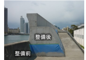
海岸堤防の整備
