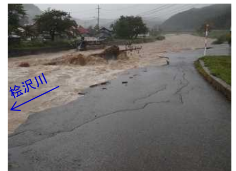
出水状況(高橋落橋)
