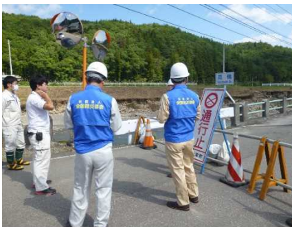
町道静川線 高橋
