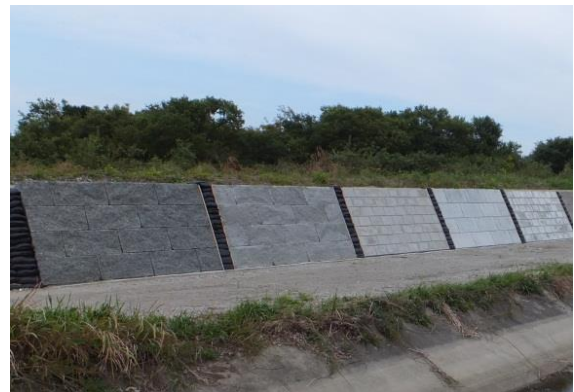
写真 2.22 景観実験護岸
