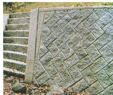
半割ブロックの小口止めの表面処理
