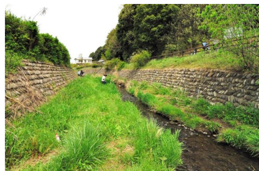
写真 2.14 露出した護岸と直線的な水際ラインの例（左）と水際部を再生した例（右）
