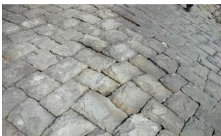
砂岩で造られた低水護岸（徳島市：左岸側）
