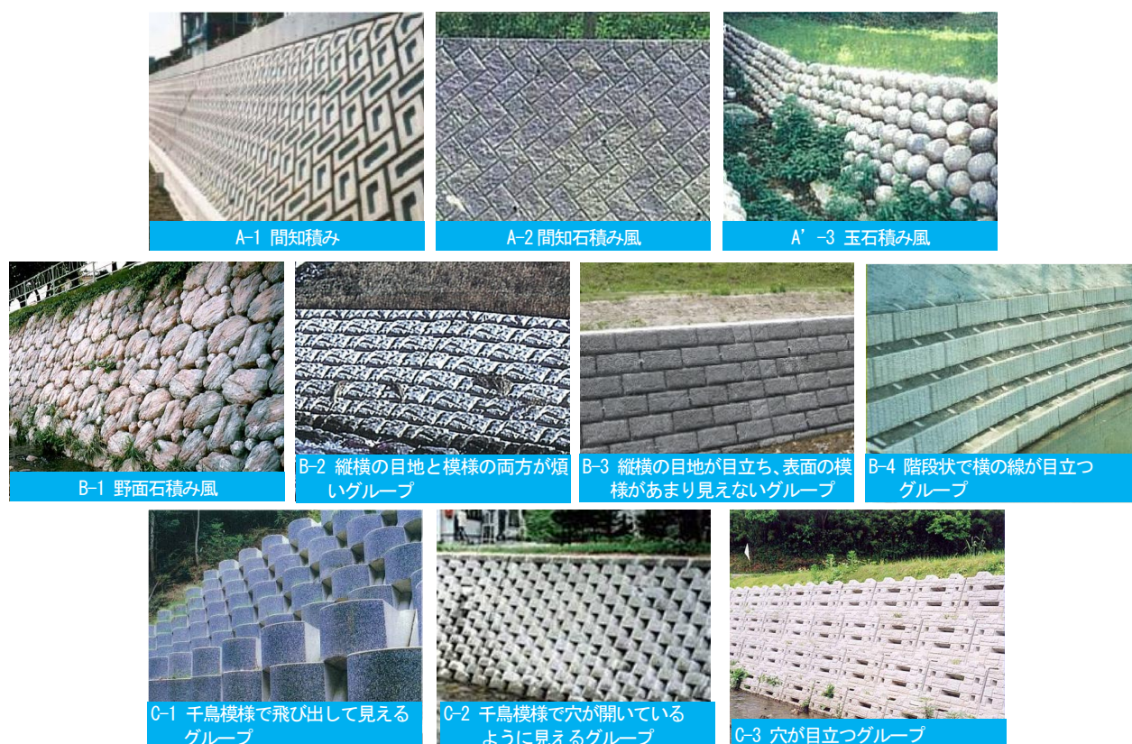
写真 2.25 KJ 法によって類型化された護岸ブロックのグループ
