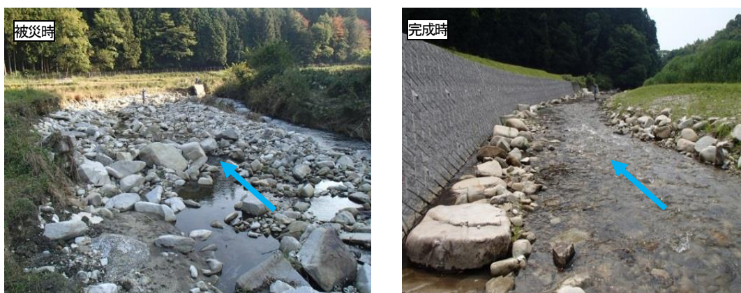
写真 2.12 河床の巨石を撤去した事例
