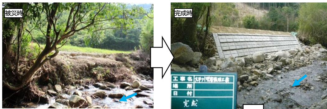
写真 2.43 寄石と覆土により水際の多様性と植生を復旧した事例（三刀屋川：島根県）
