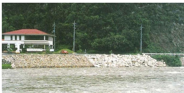
写真 2.29 左 素材1個1個が識別できない例 右 素材1個1個が識別できる例
