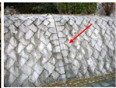
半割ブロックの小口止めの表面処理
