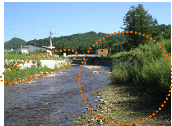
写真 2.15 現地の発生材で寄石をして自然な水際を形成している事例（元町川：岩手県）
