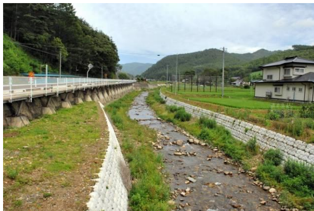
写真 2.39 天端コンクリートを打たずに土で埋め戻した事例（元町川：岩手県）
