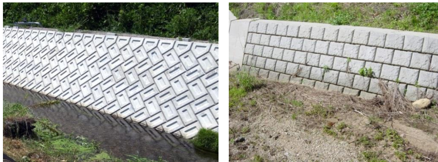
写真 2.23 谷積み(左)と布積み(右)のパターン
