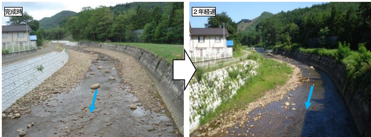
写真 2.4 災害復旧においてみお筋を保全した事例（矢神川：岩手県）
