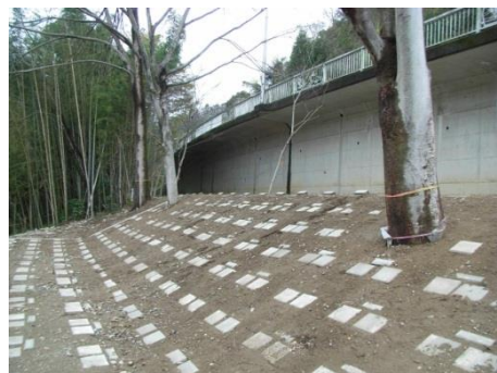
写真 2.11 低水護岸整備にあたり河畔樹木を保全した例（長良川：岐阜県）
