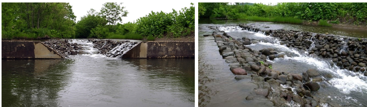
写真 2.49 下流区間の河床低下に対して落差工の一部を切り欠いて早瀬構造とし連続性を確保した事例 (倶登山川：北海道)
