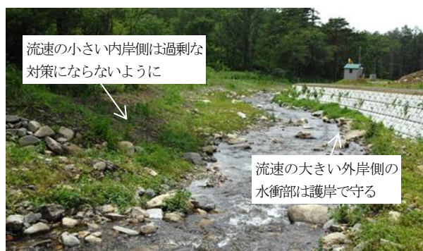
写真 2.1 背後地の土地利用及び流路の形態に応じて、河岸処理方法を変化させた例
