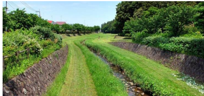
写真 2.18 周辺空間に溶け込んだ自然石護岸（和泉川：神奈川県）
