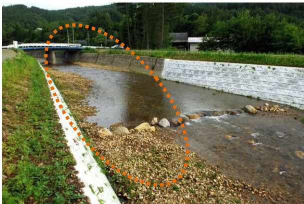
写真 2.15 現地の発生材で寄石をして自然な水際を形成している事例（元町川：岩手県）
