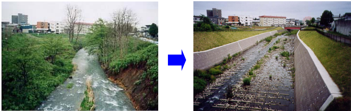
写真 2.5 復旧自然河岸を護岸にすることによる粗度が低下した例
