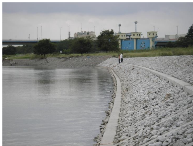
写真 2.19 明度の高い低水護岸の例
