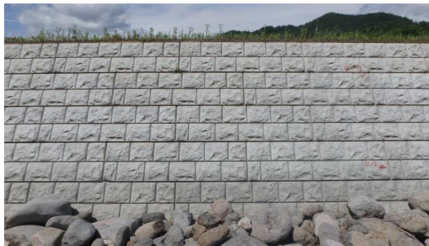
写真 2.28 ブロック内に模様目地を付けた大型ブロック
