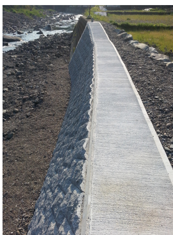
写真 2.52 天端コンクリートの表面をほうき仕上げした例
