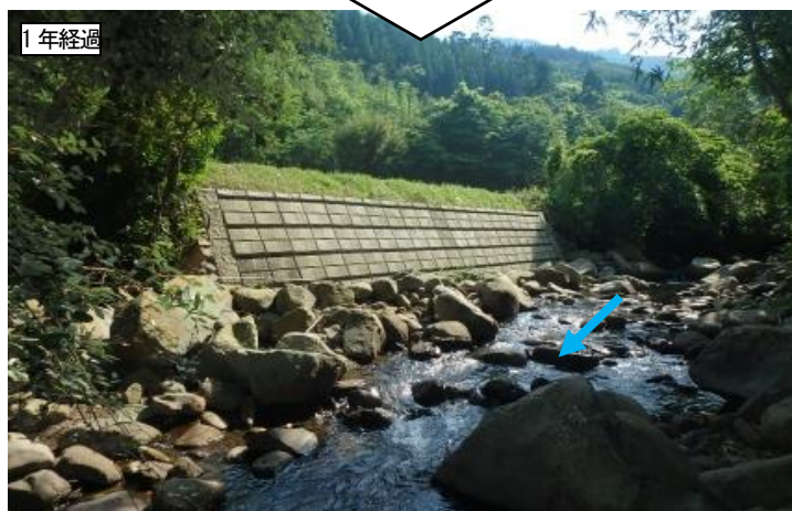
写真 2.44 河床材料との適合性の良い寄石を行った事例（大平川：宮崎県）
