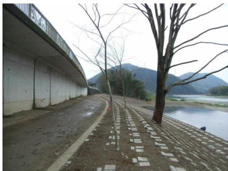
写真 2.11 低水護岸整備にあたり河畔樹木を保全した例（長良川：岐阜県）
