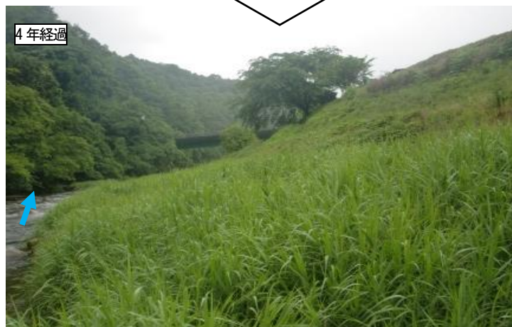
写真 2.43 寄石と覆土により水際の多様性と植生を復旧した事例（三刀屋川：島根県）
