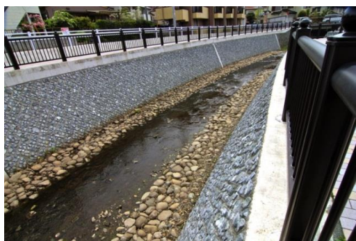
写真 2.14 露出した護岸と直線的な水際ラインの例（左）と水際部を再生した例（右）
