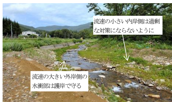
写真 2.1 背後地の土地利用及び流路の形態に応じて、河岸処理方法を変化させた例
