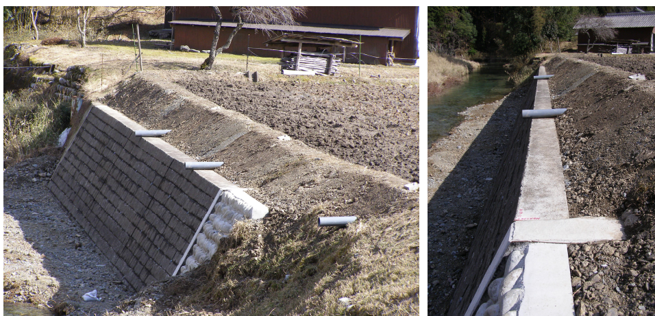
写真 2.53 天端コンクリートの表面に砂を散布して仕上げた例
