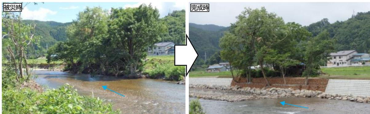
写真 3-17 河床切り下げを行いつつ河畔樹木を保全した復旧事例（雫石川：岩手県）
