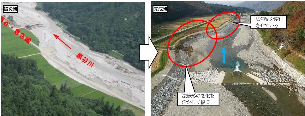
元の河道が改変されないように、現況のみお筋をスライドダウンさせ河床掘削を実施
