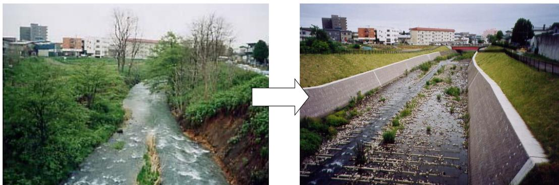
植生に覆われた改修前の河岸とコンクリート護岸が整備された改修後の河岸では粗度が異なる。
