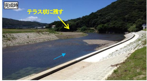
写真 3.12 片岸拡幅を行いつつ低水路の環境を保全した復旧事例（切目川：和歌山県）
