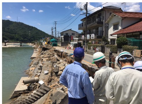
災害緊急調査状況
