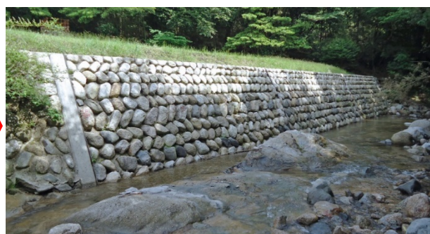
被災施設を原形で復旧
