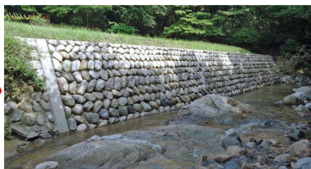
被災施設を原形で復旧
