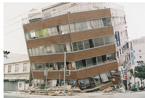
図2 被災状況(中央区)(阪神・淡路大震災)
