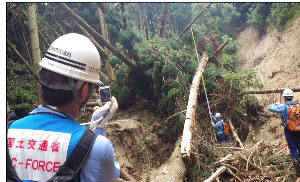
H26. 8に発生した土砂災害における被災状況把握
