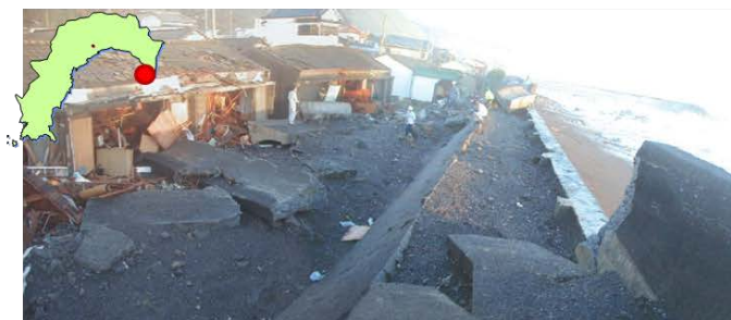
高波による葉生(なばえ)海岸の被災状況 (H16.10 高知県室戸市)
