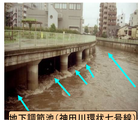
地下調節池(神田川環状七号線)
