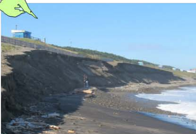
海岸侵食により汀線が大幅に後退 (茨城県大洗町)
