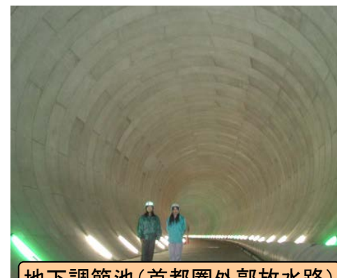
地下調節池(首都圏外郭放水路)
