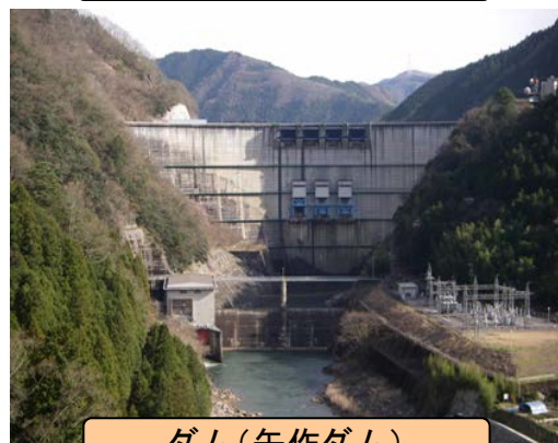
ダム(矢作ダム)
