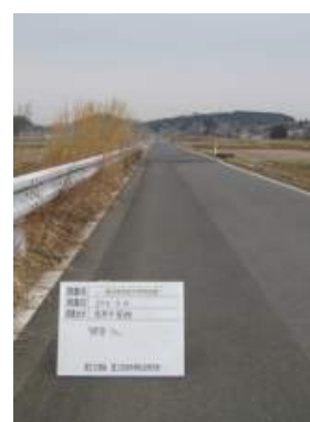
対策箇所(被害なし)
