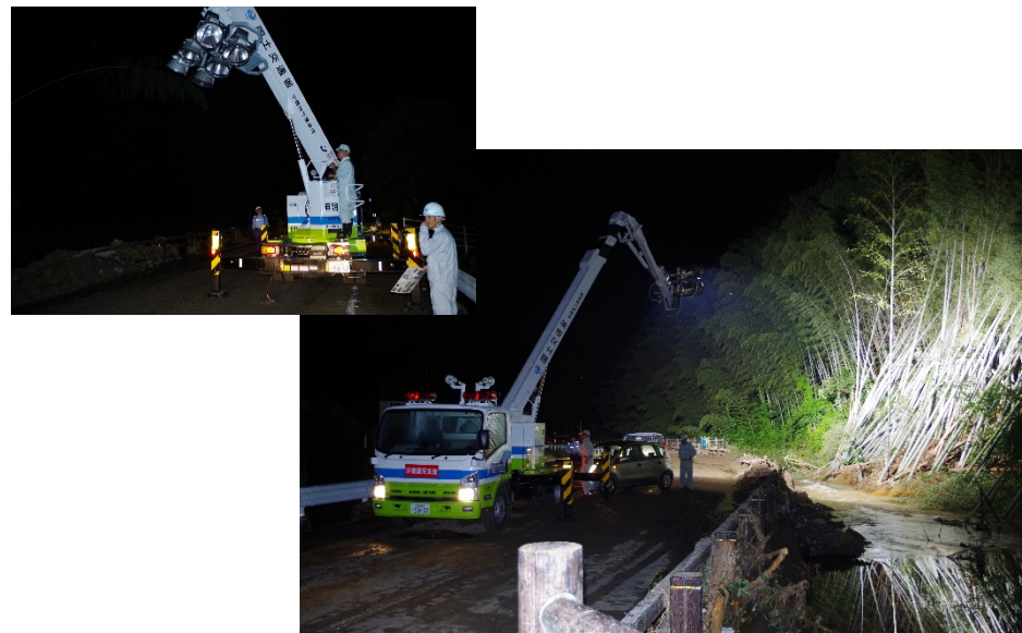
山口県和木町における照明車による復旧支援 (H26. 8. 6撮影)
