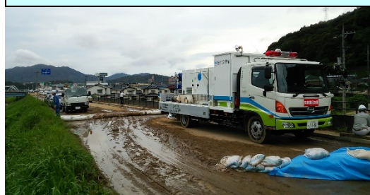
【H26.8 広島土砂災害】 (広島県広島市)
