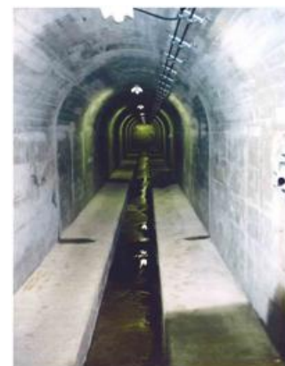
排水トンネル工
