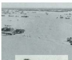
東村（現・大利根町）決壊状況
