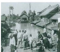
栗橋町の浸水状況
