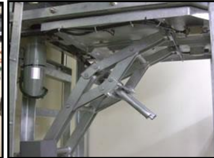
換気口浸水防止機
