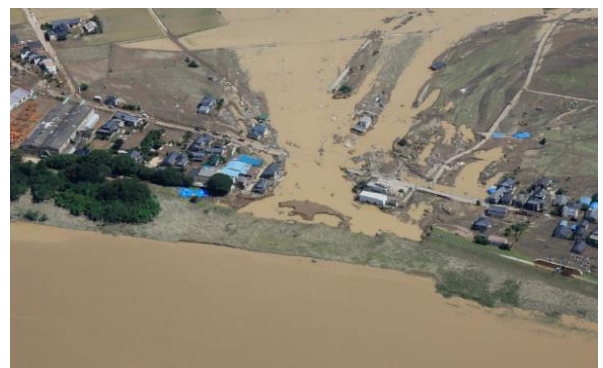
堤防決壊による家屋の流失(鬼怒川)
