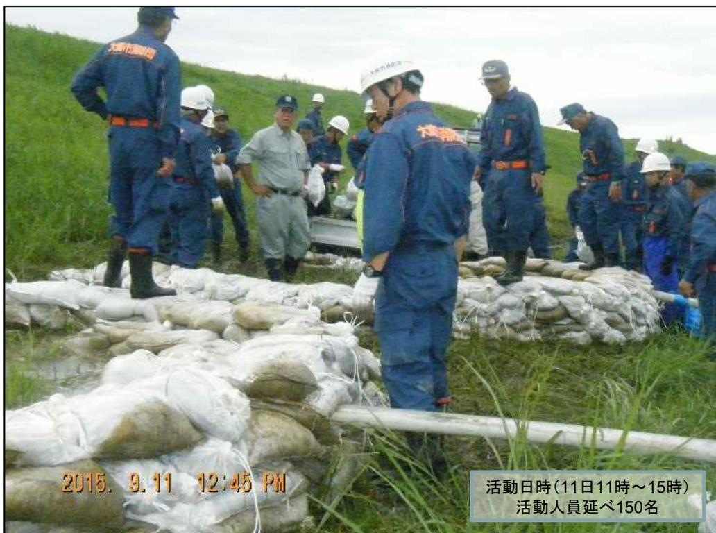
吉田川左岸：漏水箇所への月の輪工により堤防の決壊を防止。
