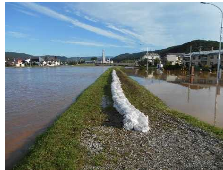
【利別川左岸】 土のう設置
