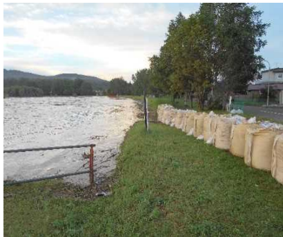
【利別川右岸】 地元の建設業者による 大型土のう設置
