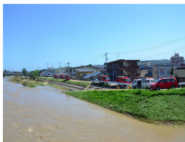
久慈川右岸内水排水作業
