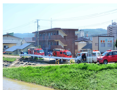
久慈川右岸内水排水作業
