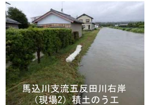
馬込川支流五反田川右岸（現場2）積土のう工
