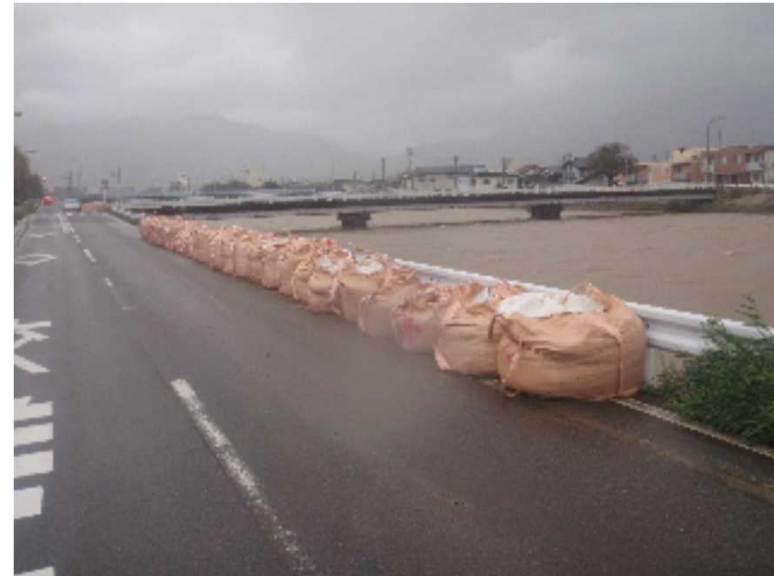
二級河川 笙の川 右岸 来迎寺橋下流側(28袋)
