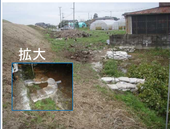
【月の輪工法 3箇所設置】
