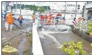
久慈川右岸内水排水作業 (新中の橋地区)
