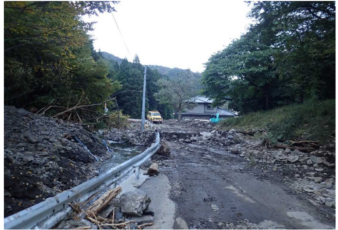
平田地区被害状況
