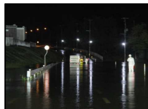
山形中央産業団地 浸水状況
