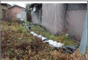
積み土のうによる水防活動 (山形町霜畑地区)
