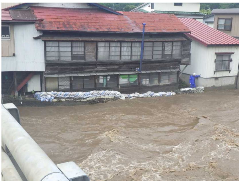
馬淵川左岸(一戸字越田橋10-13) 積み土のう工
