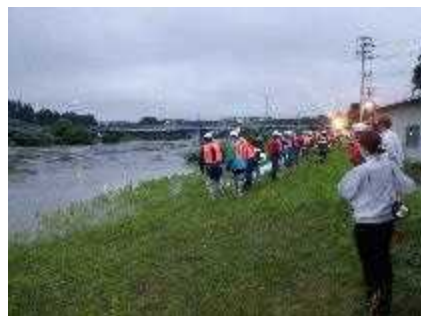
馬淵川右岸(八戸市櫛引地先) 積み土のう工
