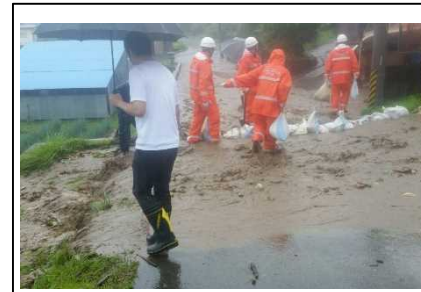
根際地内 積み土のう工
