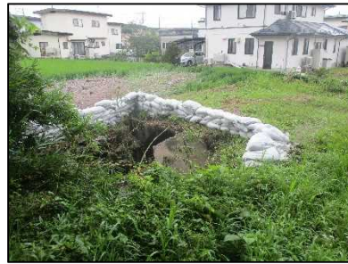
普通河川熊野川 土のう積み状況
