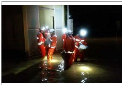
近江8丁目地内 積み土のう工
