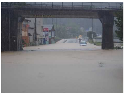
海南地区 浸水被害
