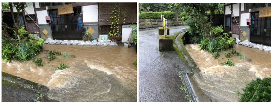
積み土のう工 (越前町広野地係)
