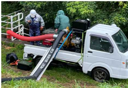
内水排除（松川町市村地区）
