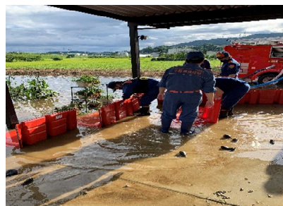
②千曲川左岸（上今井地先） ボックスウォール設置状況
