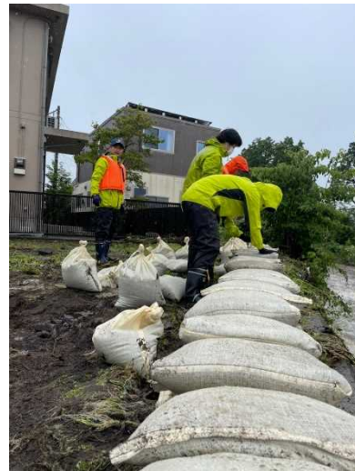
久保川左岸（竈地先） 積み土のう工
