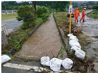
薬師川 (上野313-2地先) 積み土のう工
