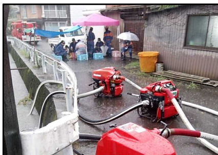
①廻里江川右岸 (廻里津地区) 可搬式ポンプによる排水作業
