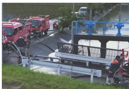
③六角川左岸 (14/000-10) 畑ヶ田排水樋管の排水作業
