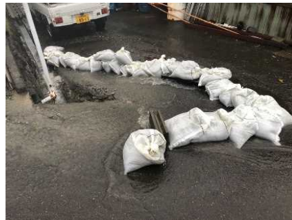
江北町土元地区 土のう積み
