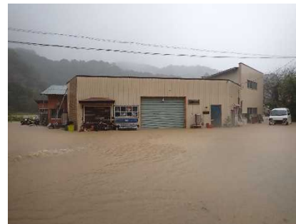
海南地区 浸水被害
