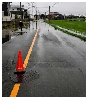
▲県道久留米小郡線 (端間駅北付近) 通行止め処置
