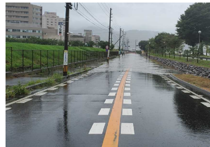
諏訪赤十字病院前湖周線 道路冠水による通行止め
