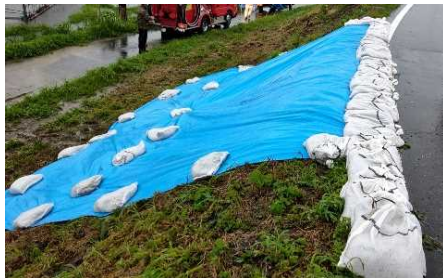
▲宝満川左岸 (稲吉橋付近) 土のう積み
