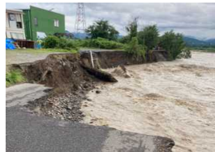
④奈良井川 (今村橋上流右岸) 堤防道路決壊
