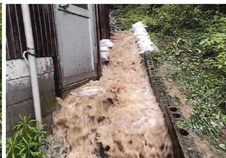
③奈井地区の浸水被害
