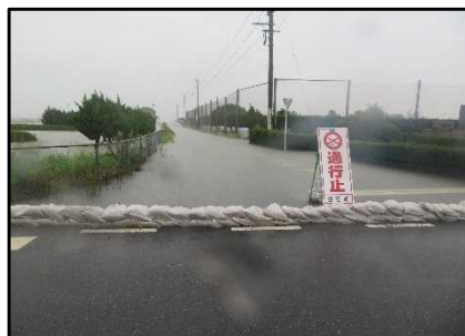
②只江川右岸 (新明地区) 土のう積み
