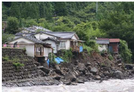
玖珠川右岸（8022番36先） ブルーシート掛け
