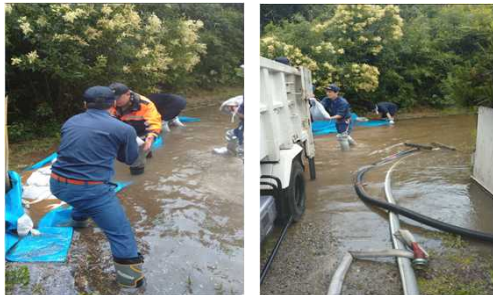
土のう積み (柳橋825番地1付近)
