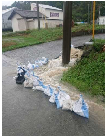
水路溢水による冠水 土のう積みによる対策 (富浦町原岡)
