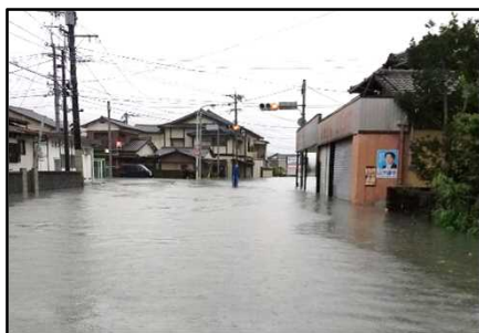
③馬田区の冠水被害状況
