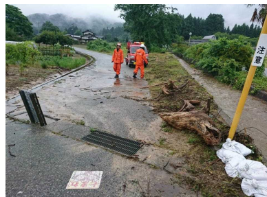
薬師川 (上野313-2地先) 積み土のう工
