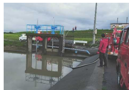
④六角川左岸 (14/000-10) 畑ヶ田排水樋管の排水作業2
