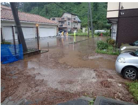
ウノキ沢（花岡地先） 排水作業
