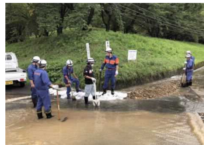
②小河川溢水に伴う 積み土のう工法
