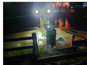
勝山陸閘閉鎖作業
