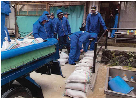
①美保関町軽尾地区 積み土のう工
