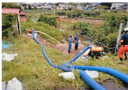
③千曲川右岸（立ヶ花地先） 排水ポンプ設置状況
