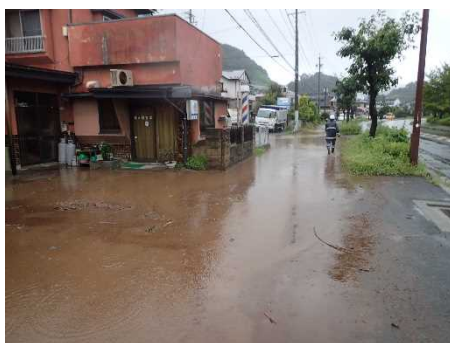
ウノキ沢（花岡地先） 排水作業
