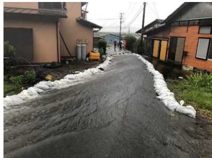
江北町土元地区 土のう積み
