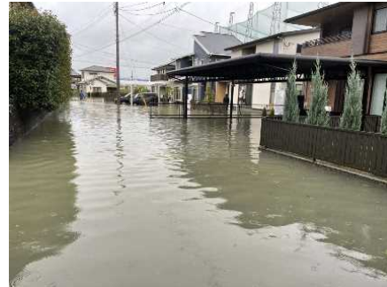
三根校区 浸水被害
