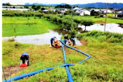
④千曲川右岸（牛出地先） 排水ポンプ設置状況
