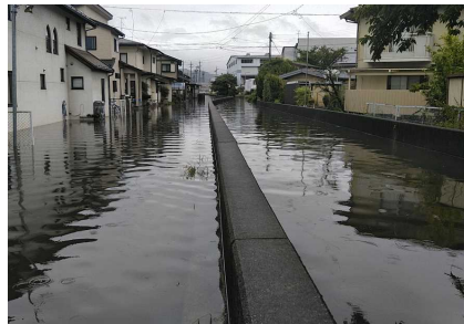
落水川左岸 (中洲5516-6地先) 河川巡視・浸水状況
