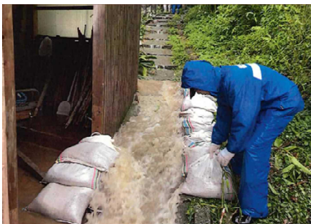
③美保関町奈井地区 積み土のう工
