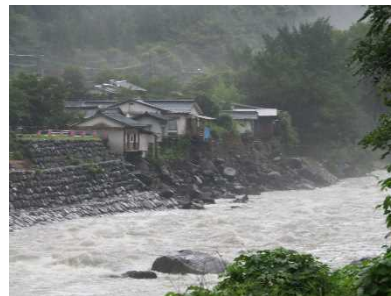
玖珠川護岸被害状況
