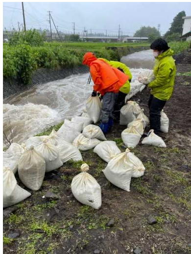
久保川左岸（竈地先） 積み土のう工
