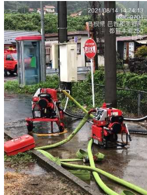
都賀地区 (避後川) 内水排水作業
