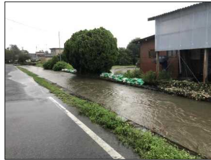
白石川右岸(上岡島137地先) 土のう設置状況
