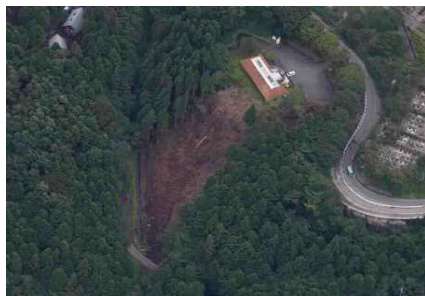
③塩嶺高原別荘地 法面崩落
