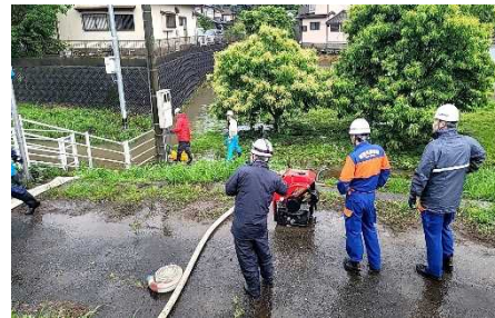
御船川左岸（大字滝川地内） 内水排水作業
