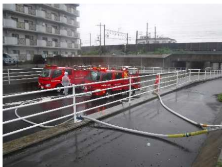
平佐一丁目 新幹線アンダーパス排水作業
