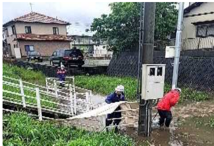
御船川左岸（大字滝川地内） 内水排水作業
