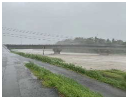
綾南川右岸 (入野橋付近) 堤防巡視
