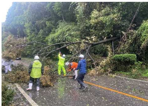
国道327号 倒木撤去
