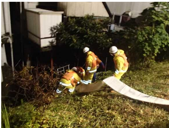
砥部川右岸 (高尾田20番地地先) 排水ホース設置
