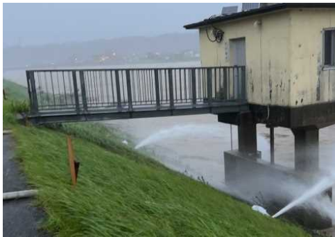
小丸川右岸 内水排水作業①
