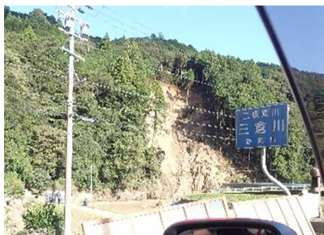
三倉川左岸の土砂崩れ 避難誘導
