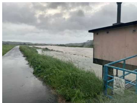
元町排水樋管 (外水側) 樋門巡視
