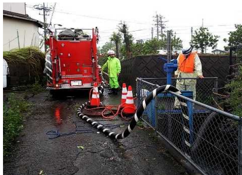
日向市南町地区 排水作業
