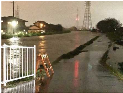
(二) 馬込川左岸 (矢矧橋北) 堤防巡視
