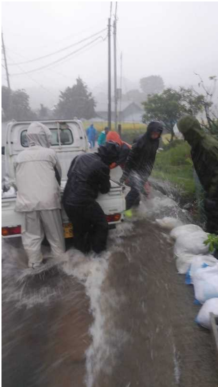
光永宮川付近 土のう積み
