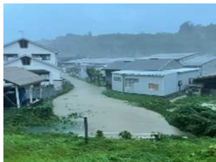
元蔵樋管 (内水側) 樋門巡視
