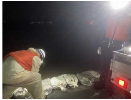
(二) 馬込川左岸 (矢矧橋北) 土のう積み
