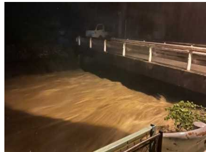
取ヶ谷戸橋 (小杉区) 水位巡視
