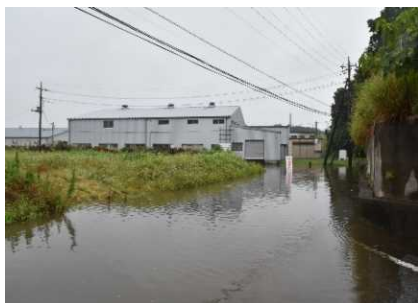
紺屋周辺の道路冠水
