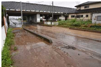
東和田地区の道路冠水被害
