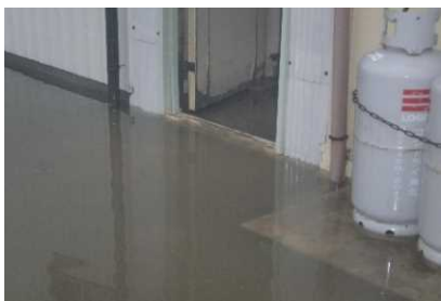
善川左岸 (古舘橋周辺) 民家浸水被害
