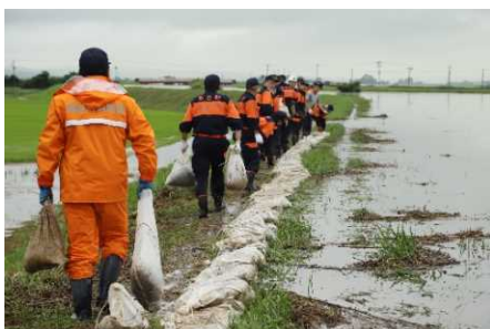
出来川左岸（渋江地先） 土のう積み、月の輪工
