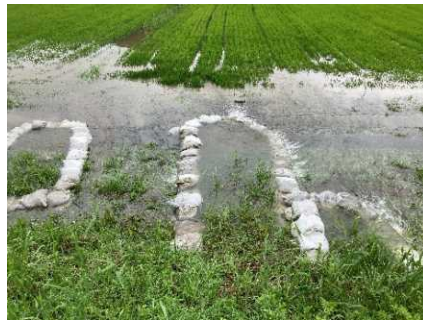
夏川堤防（居住地側） 設置後の状況
