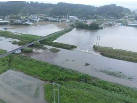
出来川右岸（名鱈地先） 破堤箇所
