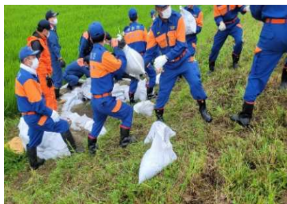
②ハサミ堤左岸（大平前地先） 月の輪工
