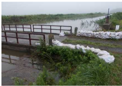
鞍坪右岸 (西福田字鱗地先) 土のう積み
