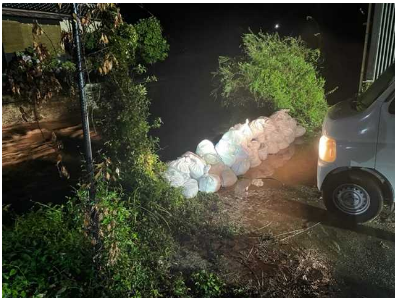
土のう積み 西田川左岸 (吉見里町二丁目)
