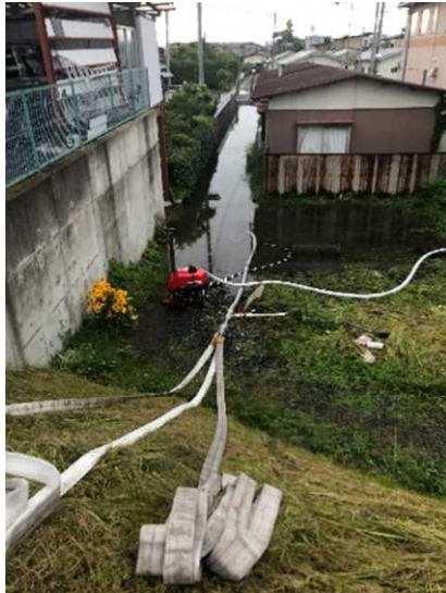
迫川左岸内水汲み取り
