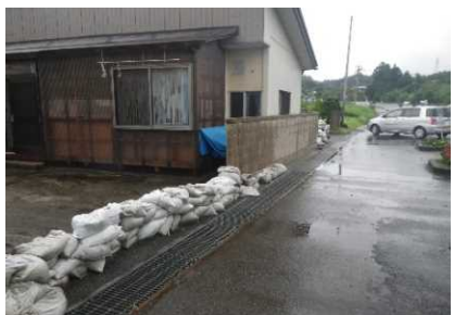
善川左岸 (古舘橋周辺) 土のう積み
