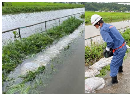
河南地区の浸水被害 (土のう積み)
