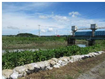
出来川右岸（名鱈地先） 土のう積み
