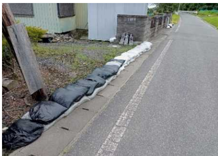
涌津字館地内内水氾濫 土のう積み
