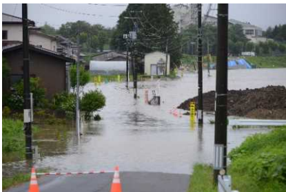
善川右岸 (海老沢橋周辺) 村道浸水被害
