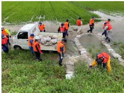
夏川堤防（居住地側） 釜段工、月の輪工
