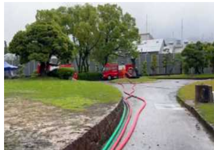
新町地区新町池 排水作業
