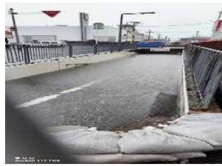
西取石7丁目地下道 積み土のう工
