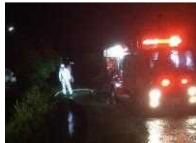
排水作業 (飯田地区)
