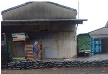
広瀬川（大場地区内） 住宅、工場等での積み土のう工
