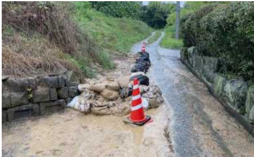
包近町 積み土のう工
