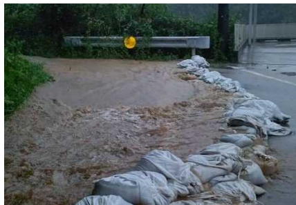
御油町筑前ヶ谷付近の浸水被害 浸水防止のため積み土のう工を実施
