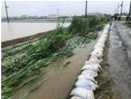
新泉川左岸 積み土のう工
