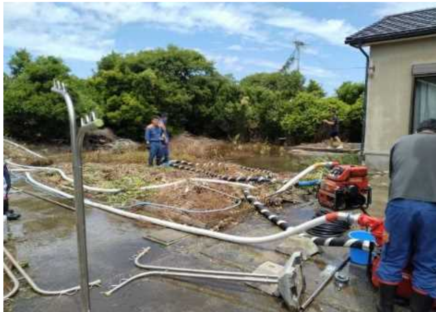
西山町地内 排水作業
