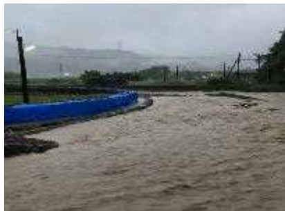
白光川（高熊地内） 河川警戒巡視・排水作業
