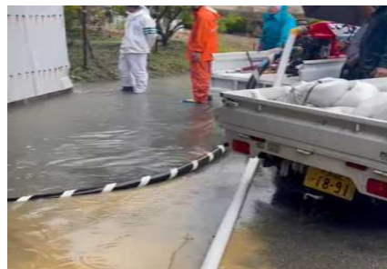
寺口地区 排水作業
