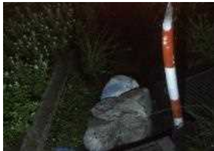
積み土のう工 (飯田地区)
