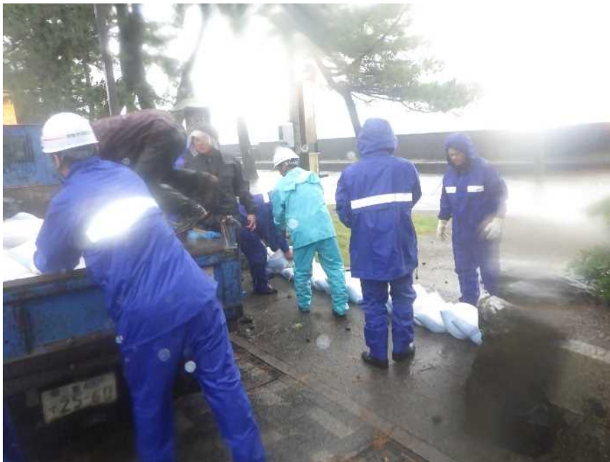
二見地区海岸（二見町茶屋地内） 積み土のう工
