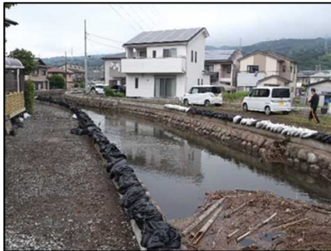
① 江尾江川 両岸 (富士市江尾地先) 積み土のう工を実施
