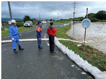
積み土のう工及び排水作業 佐田川左岸 (大刀洗町三川地先)
