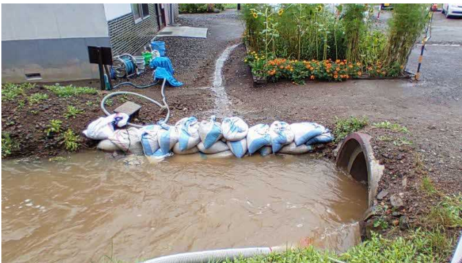
積み土のう工
