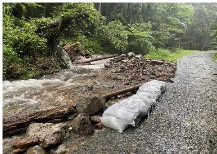
山口川左岸 積み土のう工
