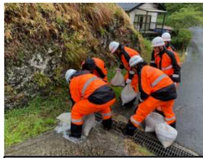
⑥ 夜久野町末地区 水路の越水による道路冠水を防ぐため土のうを設置
