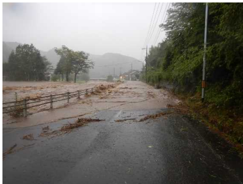
①加茂川右岸 積み土のう工
