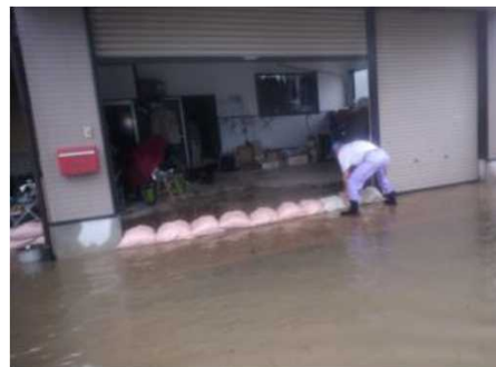
沿川の住宅への積み土のう工 (岐阜市北野西山地先)
