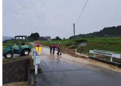
小畑町 土砂の除去作業
