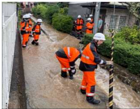
③ 夜久野町額田地区 水路の越水を防ぐため土のうを設置
