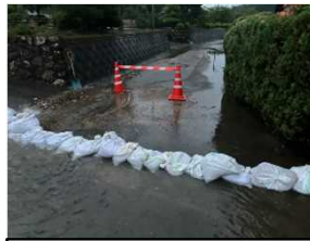
⑤ 夜久野町板生地区 住宅敷地へ山水の流入を防ぐため土のうを設置
