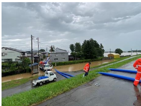
大曲地域 排水作業
