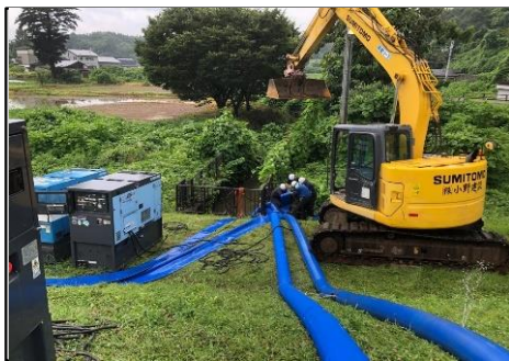
雄物川右岸 排水ポンプによる排水作業
