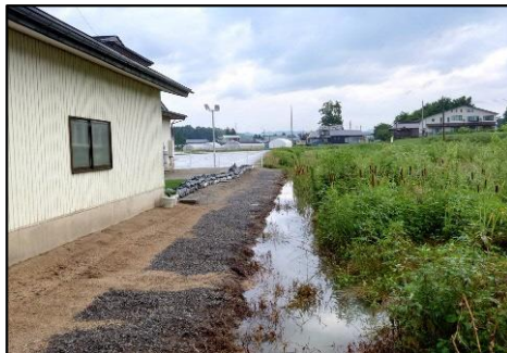
内水対応積み土のう工 (西大塚地内:翌日写真)
