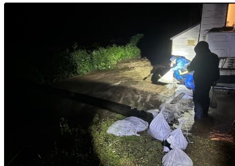
新町川 土嚢積み
