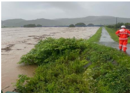
津谷地区の浸水被害 堤防の監視
