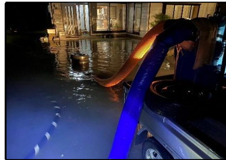
内水対応（西大塚地内） 排水ポンプによる排水作業
