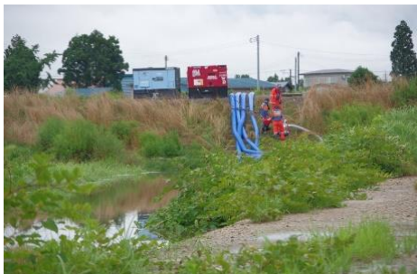
南外地域 排水作業
