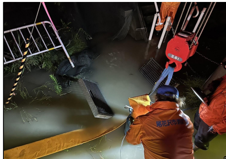
毒沢地区（内水氾濫） 排水ポンプによる排水作業
