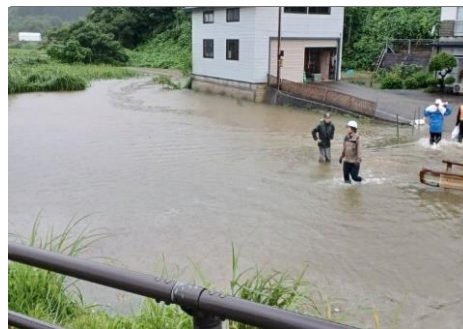
雄物川右岸 冠水状況
