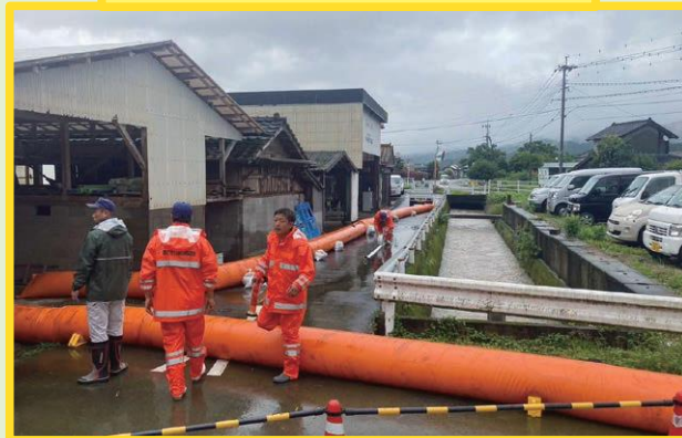
水防工法(大型水のう)
