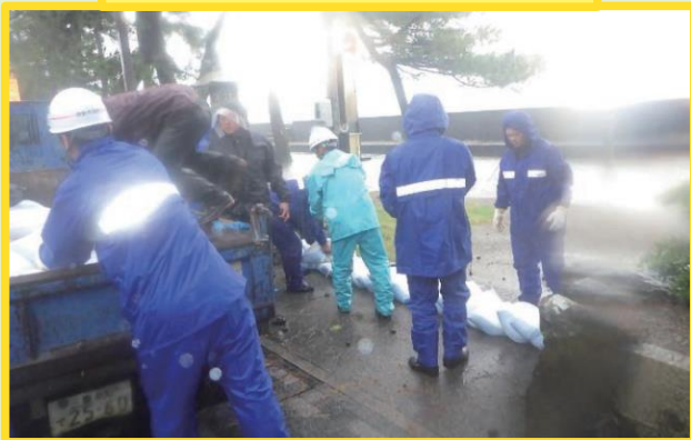
水防工法(土のう積み)
