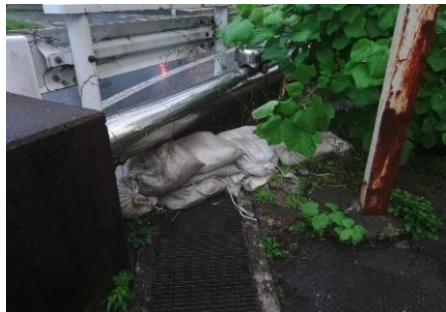
後藤川（平館地内） 積み土のう工
