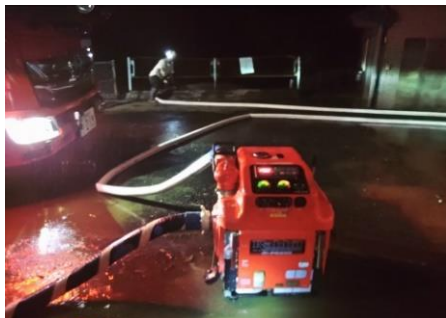
平館地区 消防ポンプによる排水作業
