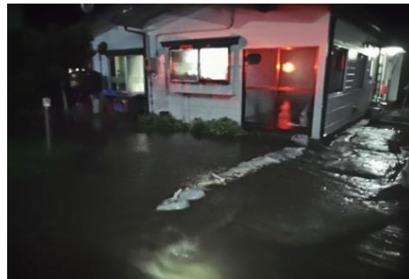
平館地区の床下浸水被害 積み土のう工
