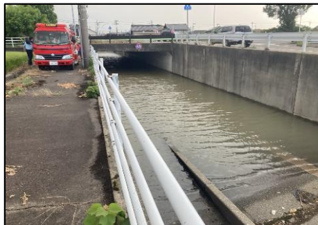
長竹アンダー（長竹町地先） 排水ポンプ車による排水作業
