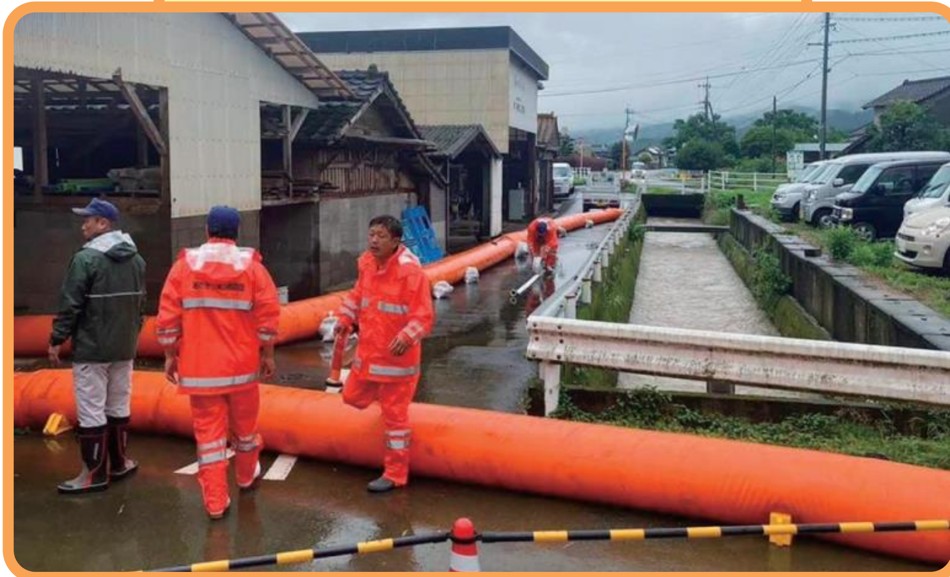
水防工法(大型水のう)
