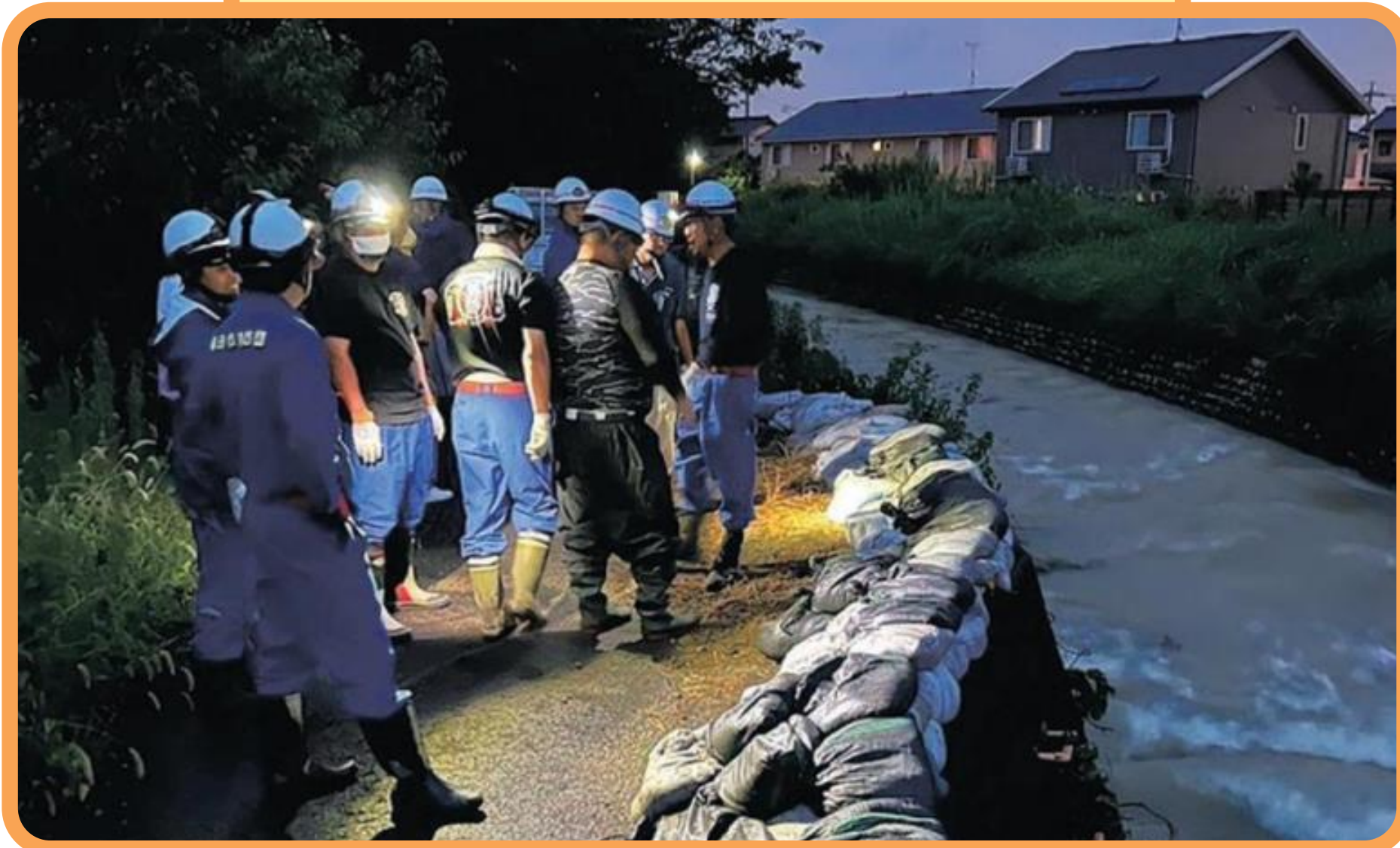
水防工法(土のう積み)
