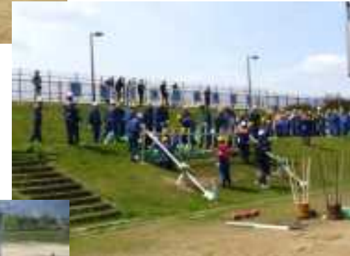
杭打ち積み土のう工
