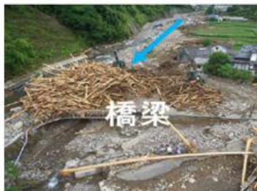
図.技 2-1-4-1 大量の流木堆積が生じた事例
