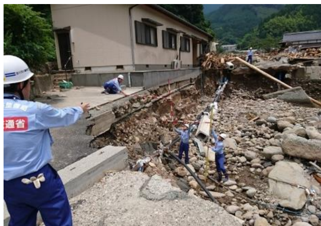
河川被害状況の調査
