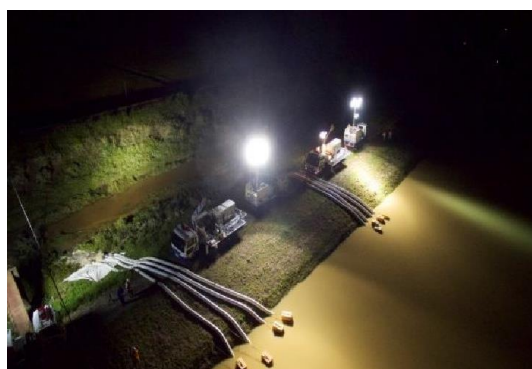
夜間排水作業を照らす照明車
