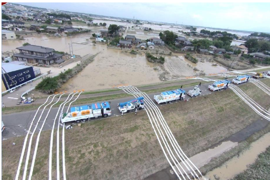
浸水を早期に解消するため活動する排水ポンプ車
