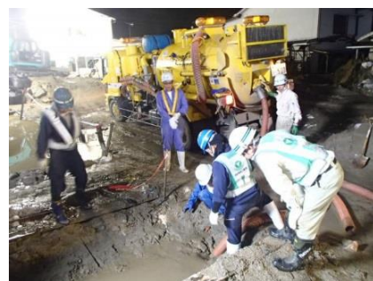
側溝清掃車による 堆積土砂の撤去
