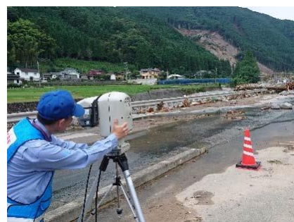
斜面崩壊現場の 24時間監視
