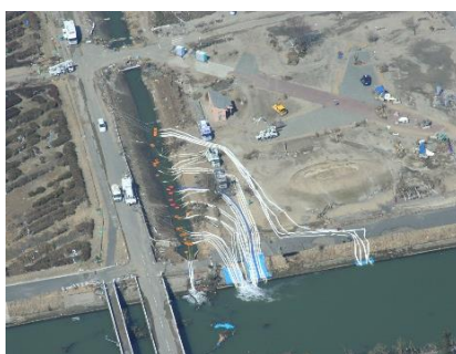
自治体所管施設の 被災状況調査
