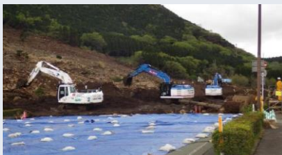
遠隔操作式バックホウによる土砂撤去作業
