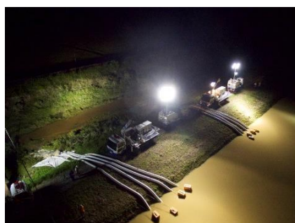
排水ポンプ車による 緊急排水
