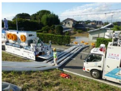
排水ポンプ車による排水状況
