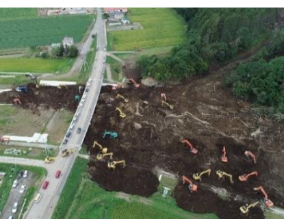
河道閉塞箇所において24時間体制で土砂撤去を実施
