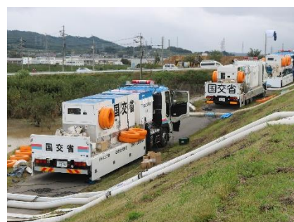
排水ポンプ車による 緊急排水作業
