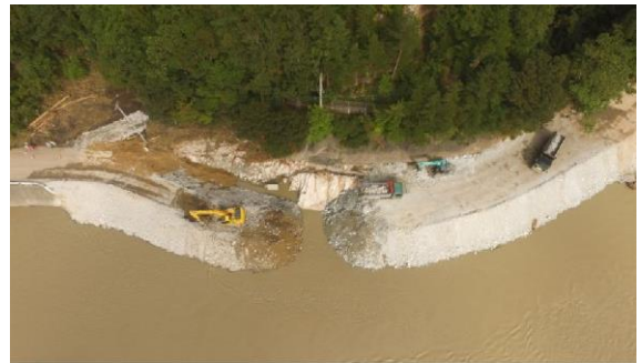
洪水で流出した区間を 盛土により再生した事例
