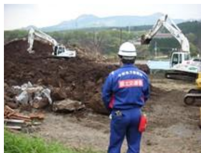
無人バックホウによる 堆積土砂の撤去
