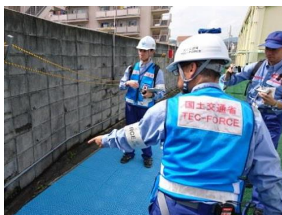
被災したブロック塀の 応急危険度判定を実施
